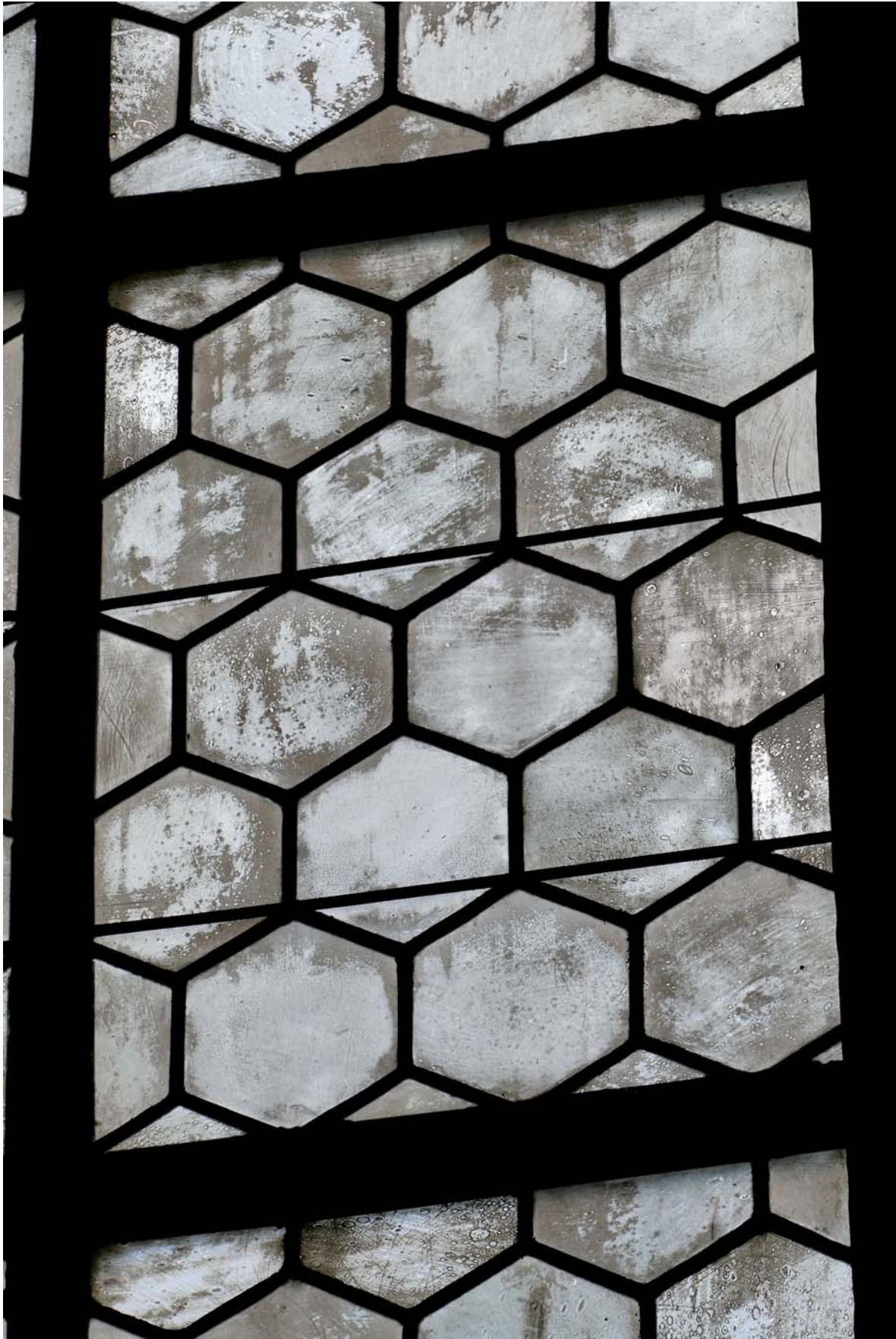
Schlecht: Das Kirchenfenster ist durch Ruß verschmutzt.
